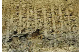
Baustelle im Amaltheenton
